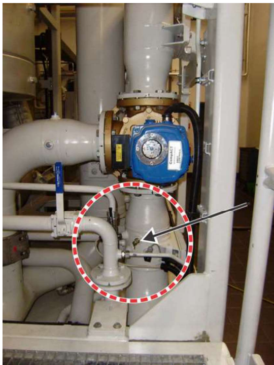
Място за вземане на проба от маслото под клапана АМОТ
